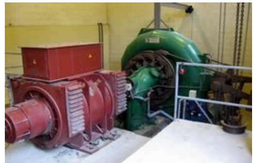
Le groupe turbo-alternateur, composé d'une turbine du type Francis double.
